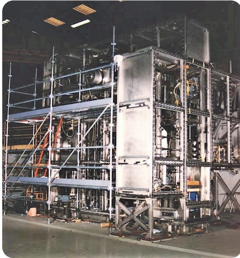
➤ Stockage et manutention des poudres
