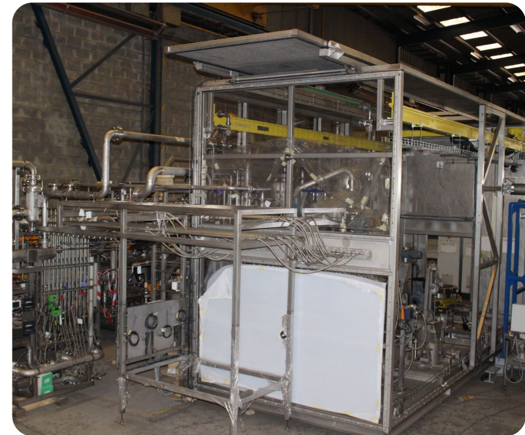
➤ Enceinte de confinement et pont roulant
