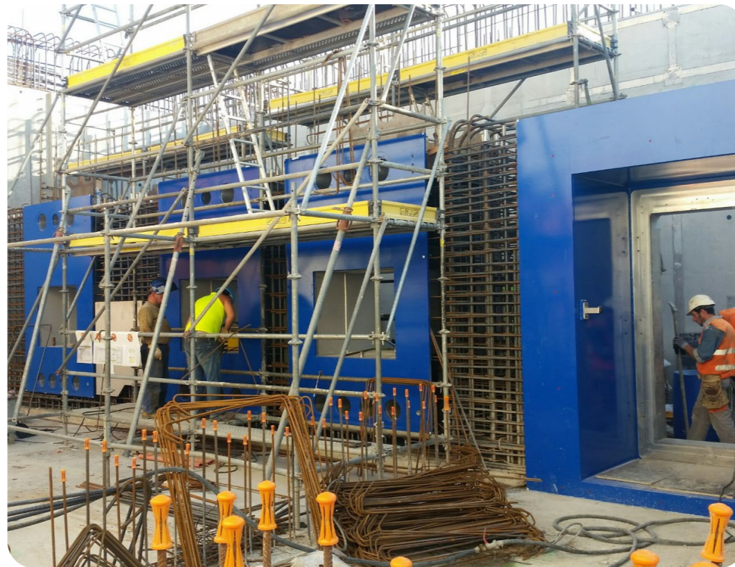
➤ Installation des pièces noyées
